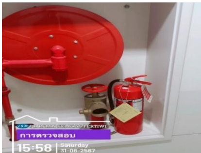
งานบำรุงรักษาตรวจเช็คตู้เก็บสายฉีดน้ำดับเพลิง (ตู้ FHC)
