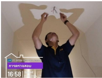
งานบำรุงรักษาตรวจเช็คระบบ Fire Alarm (เปลี่ยน smoke detector)
