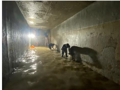
ล้างถังเก็บน้ำสำรองและตรวจเช็คสภาพถังเก็บน้ำสำรอง (วันที่ 30 ก.ค. 67) รูปที่ 2.1-9 ระบบน้ำใช้โครงการ (ต่อ)
