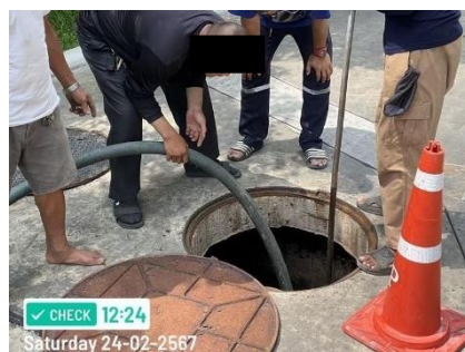
สูบล้อกรองกากตะกอนส่วนเกินระบบบำบัดน้ำเสีย ประจำปี 2567 (วันที่ 24 ก.พ. 67)
