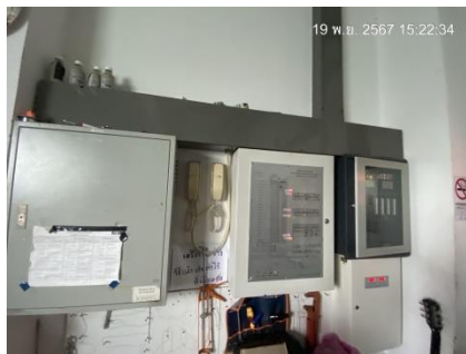
ตู้ควบคุมระบบแจ้งเตือน
